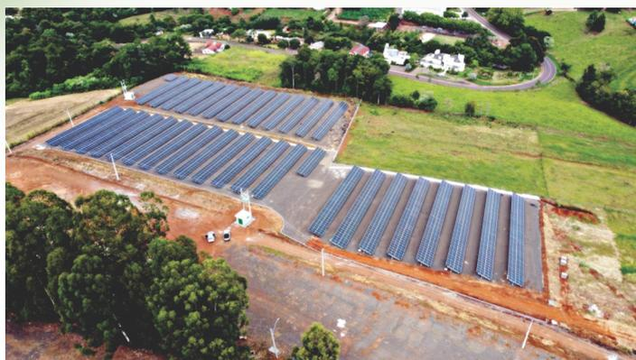
Projeto com 2.744 módulos solares de 510 watts em Palmitos, SC
